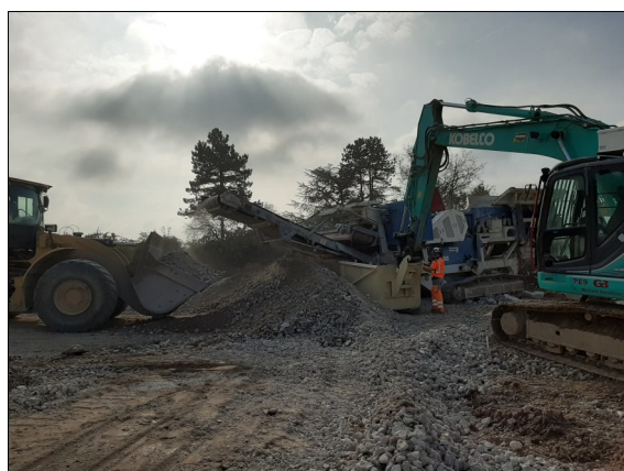
Concassage des bétons issus de la démolition
