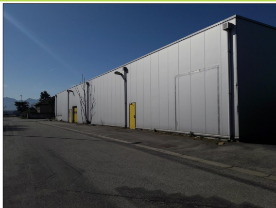
Bâtiment de stockage frigorifique à démolir
