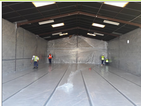
Bâtiment en cours de confinement
