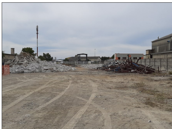
Tri des matériaux de déconstruction avant valorisation
